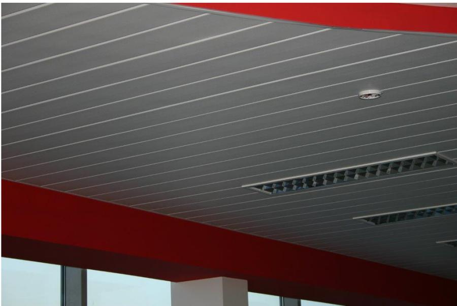
Neben dem Standardpaneelsystem AL-KF ist das System AL-KG fast identisch und fast gleichhäufig anzutreffen. Dieses System hat im Gegensatz zum System AL-KF eine geschlossene Fuge.
