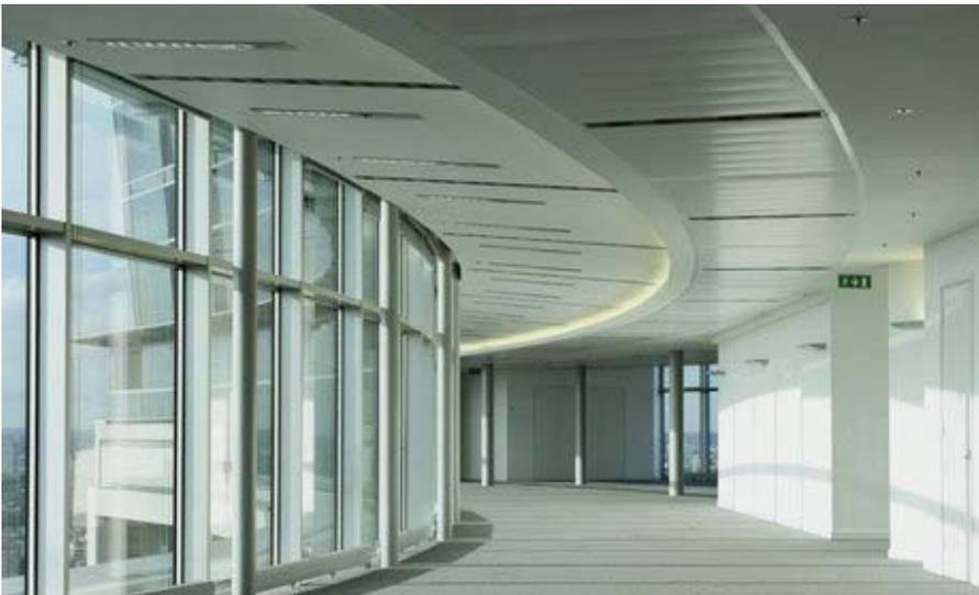
Das stumpf gestoßene Paneelsystem AL-C ist ein optimales System für erhöhte Ansprüche. Im geschützten Außenbereich, wie Vordächer kann das System mit korrosionsgeschützter Unterkonstruktion optimal eingesetzt werden.
