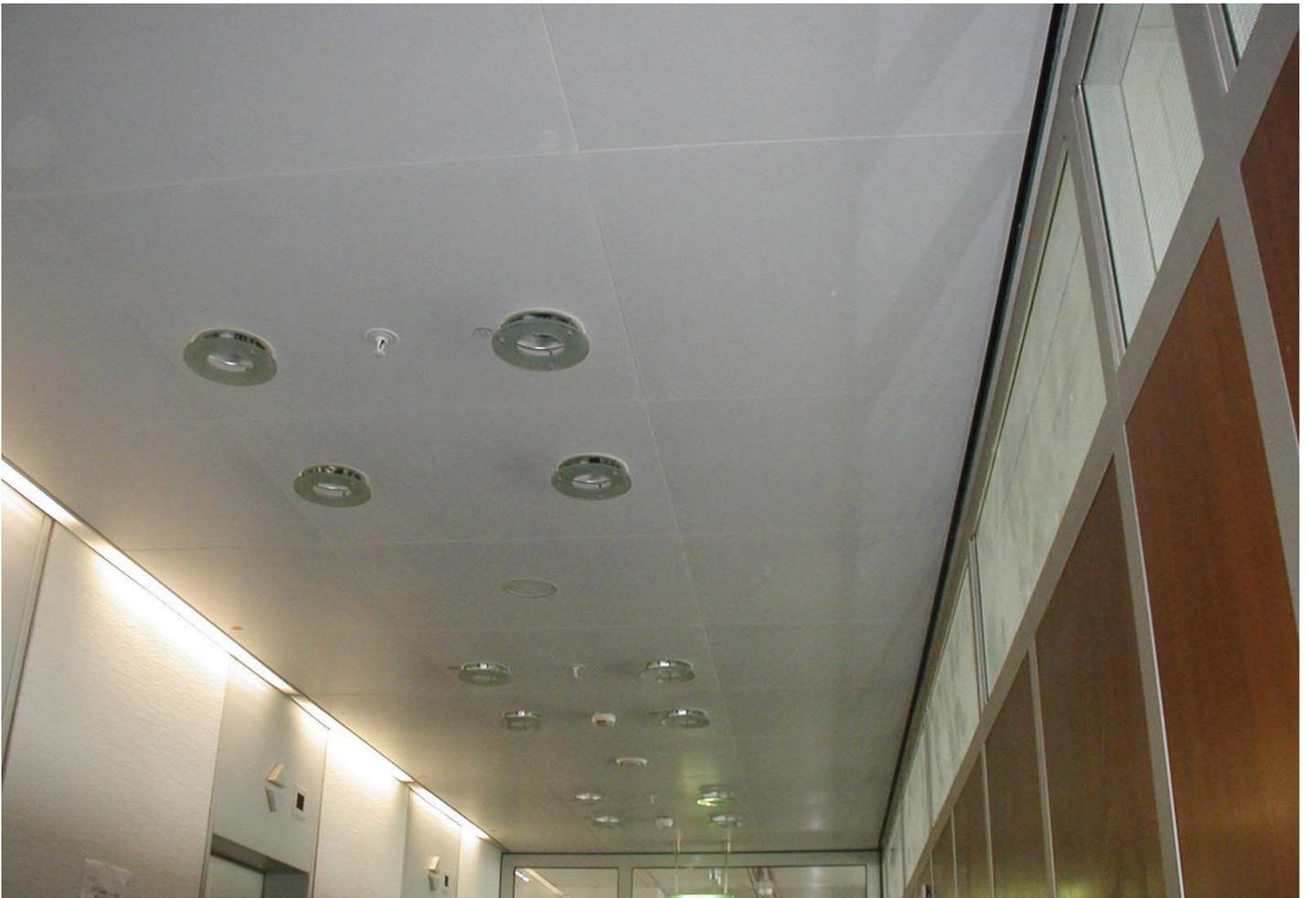
Metall-Quadratkassetten können in fast allen Bereichen eingesetzt werden, wo keine höherwertige Anforderungen, wie Korrosion, Brandschutz... notwendig sind. Ob Büro, Krankenhaus, Fertigungshallen, überall finden Quadratkassetten ihren Zuspruch.
