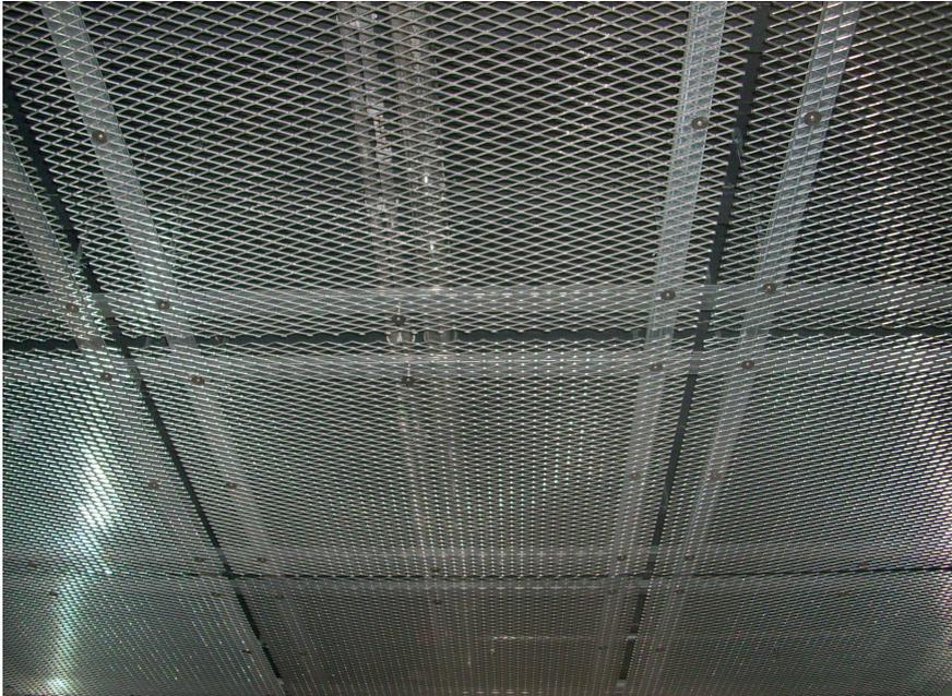
Die Unterkonstruktion besteht aus CD-Profilen, welche auf Kreuz im Stoß montiert werden. Die CD-Profile sind, wie die Noniushänger in mind. C3L zu beschichten und mind. 4 Stück je qm. Deckenfläche, welche durch das statische Gutachten anders ausfallen können. Das Gleiche gilt auch für den Korrosionsschutz, welche bei Salzwasser in der Nähe auch wesentlich höher ausfallen kann.
